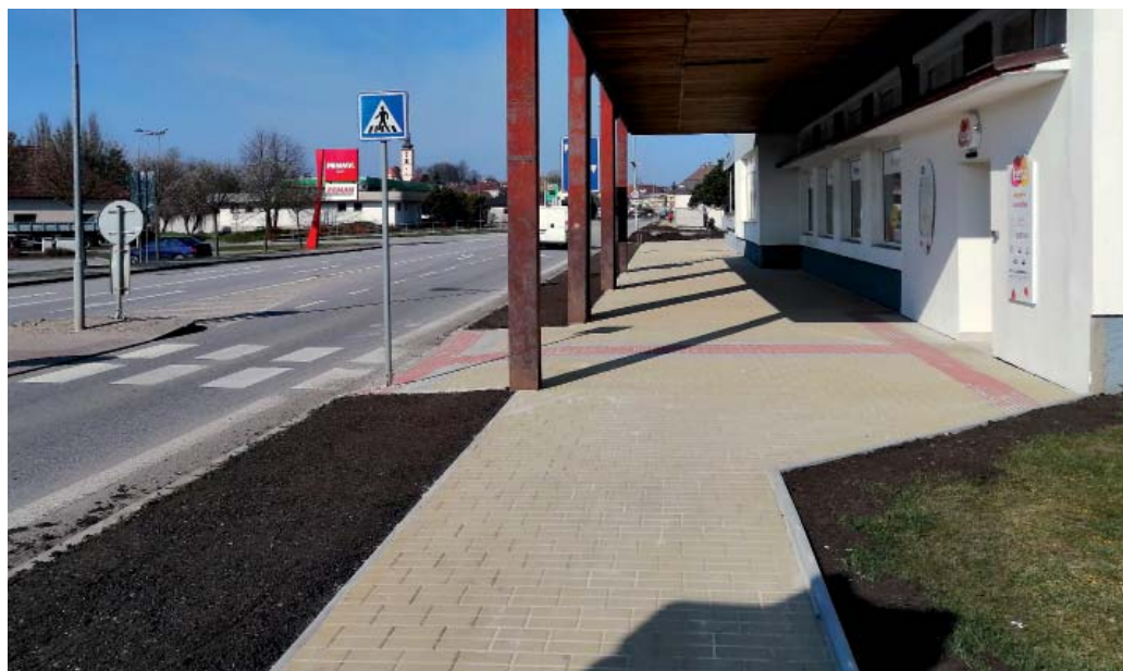
Rekonstrukce chodníků ve Veselí nad Lužnicí
